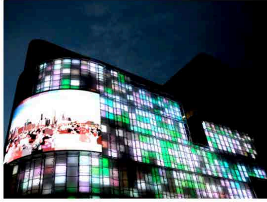
Görsel 60: Singapur'da 500'ün Üzerinde LED Ekrandan Oluşan Bir Ofis Binası Cephesi https://www.webdesignerdepot.com/2009/08/30-dazzling-and-interactive-media-facades/ , 31.10.18)
