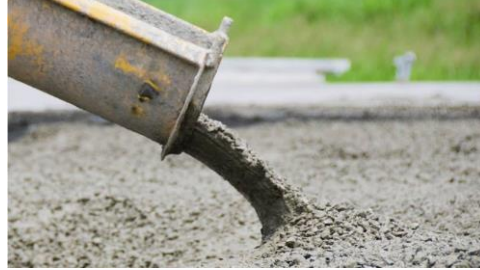
Şekil 2.16. Beton Döküm Aşaması (Kaynak: URL 11)
