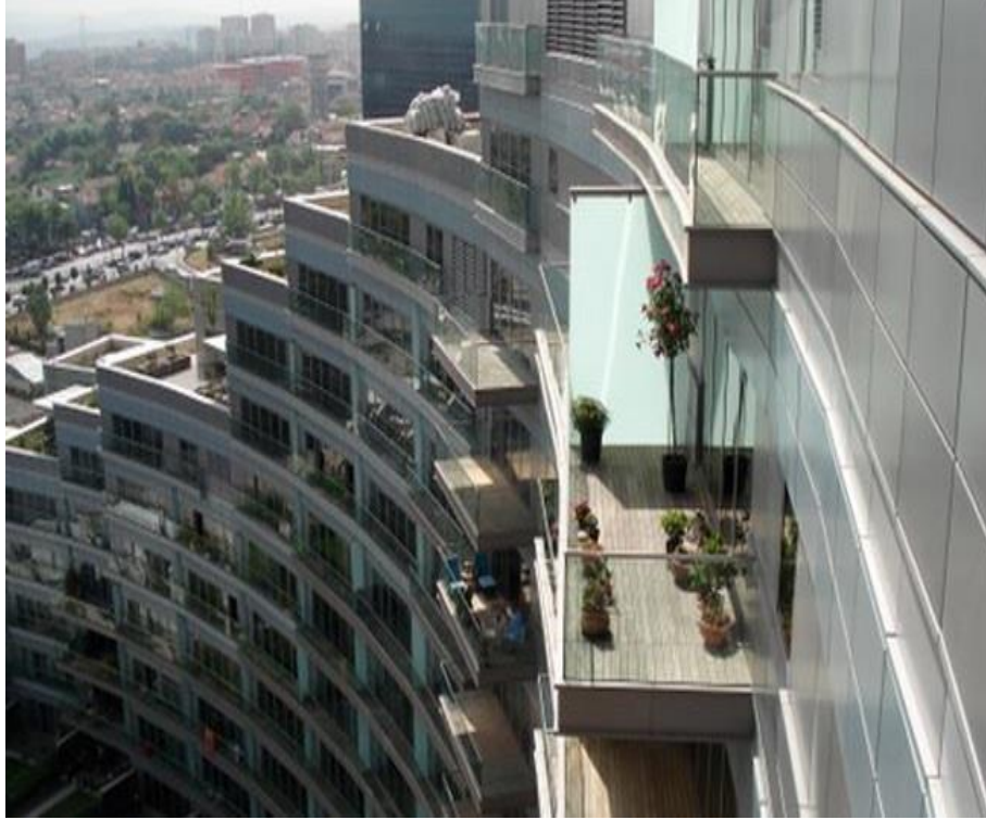
Resim 3.26. Kanyon Rezidans Dış Cephe
