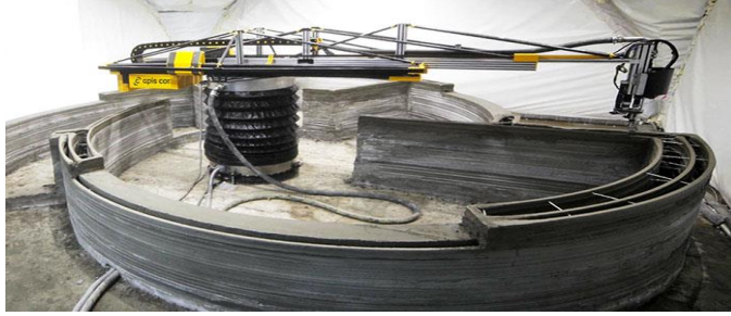
Resim4.6. ApisCor evinin inşasında kullanılan üç boyutlu yazıcı (URL58)
