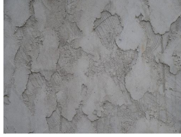
Resim 4.10. Beton duvar örneği (URL 88)
