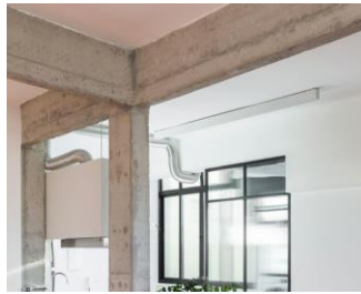
Resim 2.28. Betonarme kiriş örneği (URL 34)
