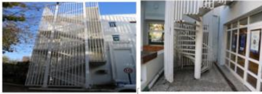
Foto 12. Ayazağa Işık İlköğretim Okulu yangın (URL,22).
