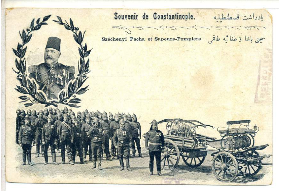
Resim 4.3: Askeri İtfaiye Taburu ve Szechenyi Paşa, Seraskerlik Binası Önünde Tatbikata Hazır Beklerken, 1880-90.
