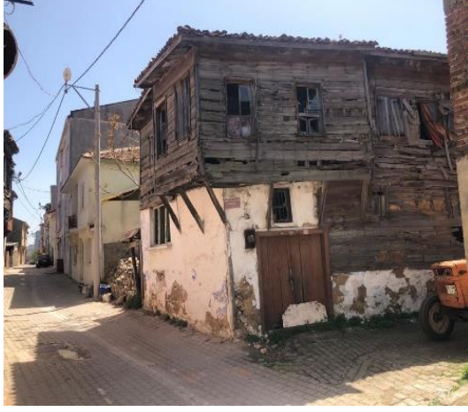
Resim 3.45 C17 – Cephe Görünümü
