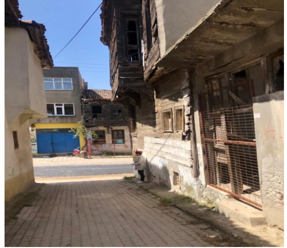
Resim 3.35 C9 – Cephe Görünümü
