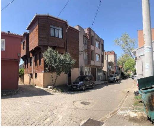
Resim 3.52 C26 – Cephe Görünümü
