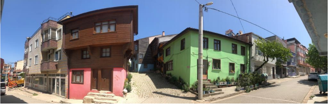
Resim 3.29 C3 – Cephe Görünümü
