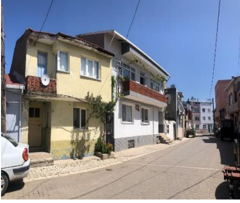
Resim 3.48 C22 – Cephe Görünümü
