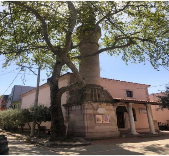
Resim 3.30 C4 – Cephe Görünümü
