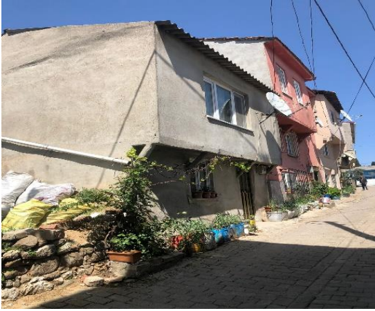
Resim 3.50 C24 – Cephe Görünümü
