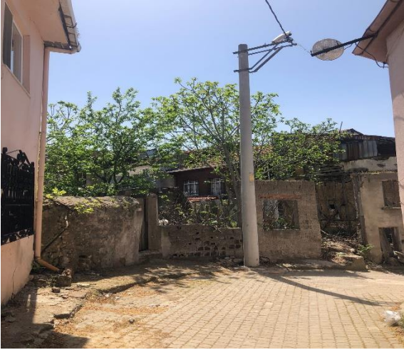
Resim 3.34 C8 – Cephe Görünümü
