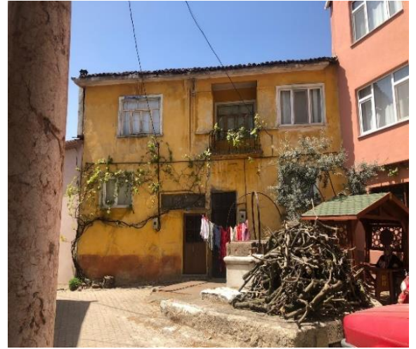
Resim 3.31 C7 – Cephe Görünümü
