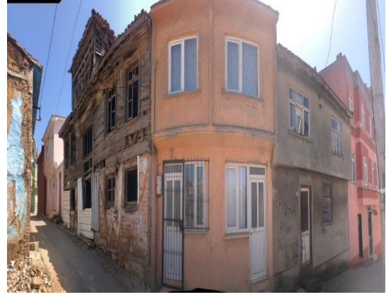
Resim 3.53 C27 – Cephe Görünümü
