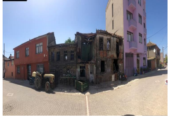
Resim 3.49 C23 – Cephe Görünümü
