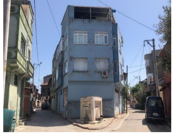
Resim 3.51 C25 – Cephe Görünümü
