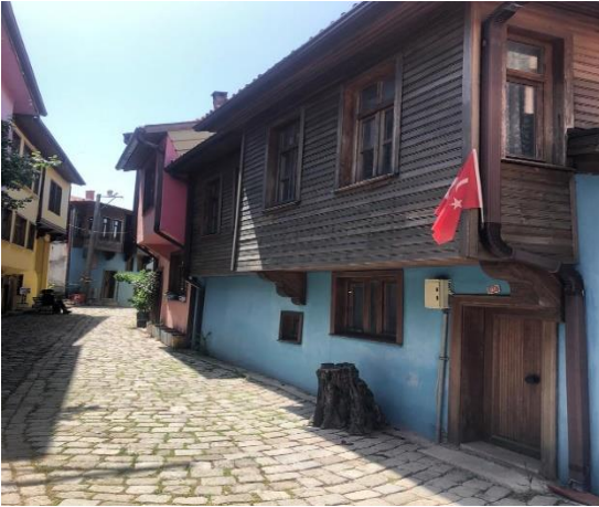
Resim 3.27 C1 – Cephe Görünümü
