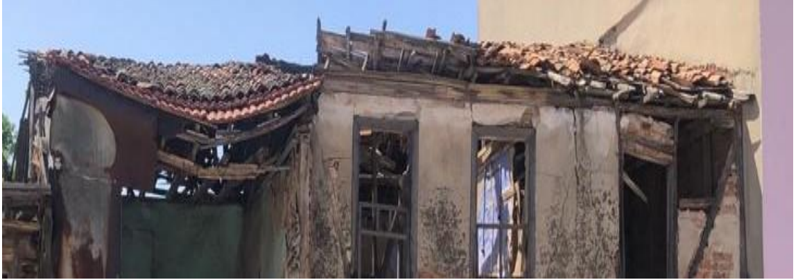
Resim 3.24 Edincik Evlerinden Oluklu ve Alaturka Kiremitli Kırma Çatı Örnekleri
