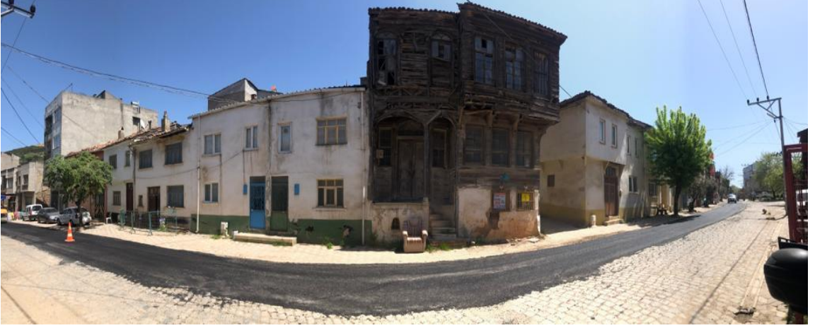
Resim 3.36 C10 – Cephe Görünümü
