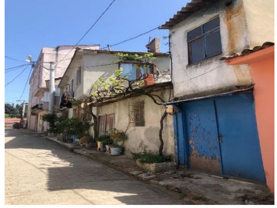
Resim 3.33 C6 – Cephe Görünümü
