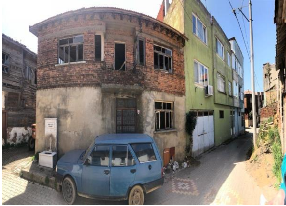
Resim 3.43 C18 – Cephe Görünümü
