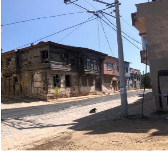
Resim 3.38 C12 – Cephe Görünümü
