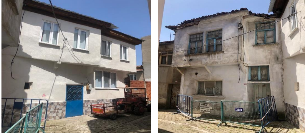
Resim 3.55. C29 – Cephe Görünümü
