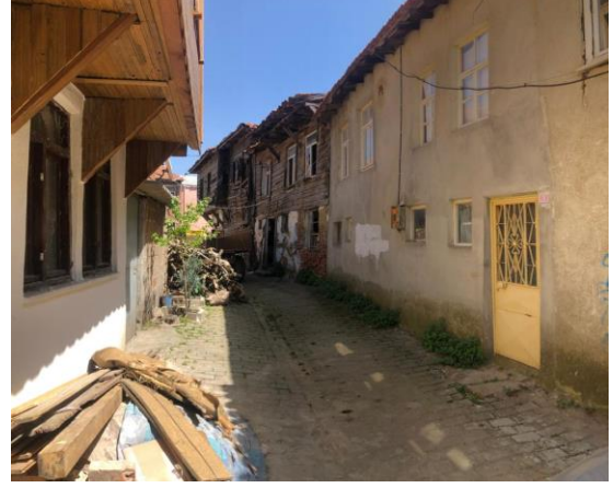
Resim 3.42 C16 – Cephe Görünümü
