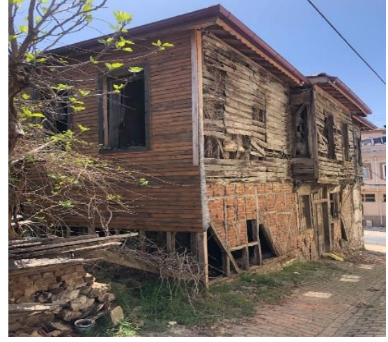
Resim 3.39 C13 – Cephe Görünümü
