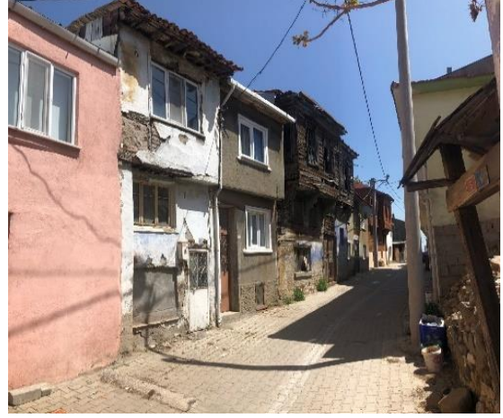
Resim 3.46 C20 – Cephe Görünümü
