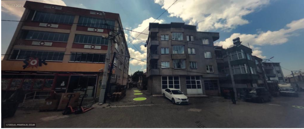
Resim 3.54 C28 – Cephe Görünümü
