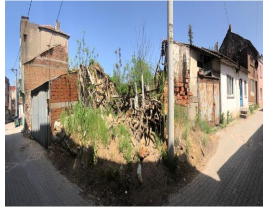
Resim 3.44 C19 – Cephe Görünümü
