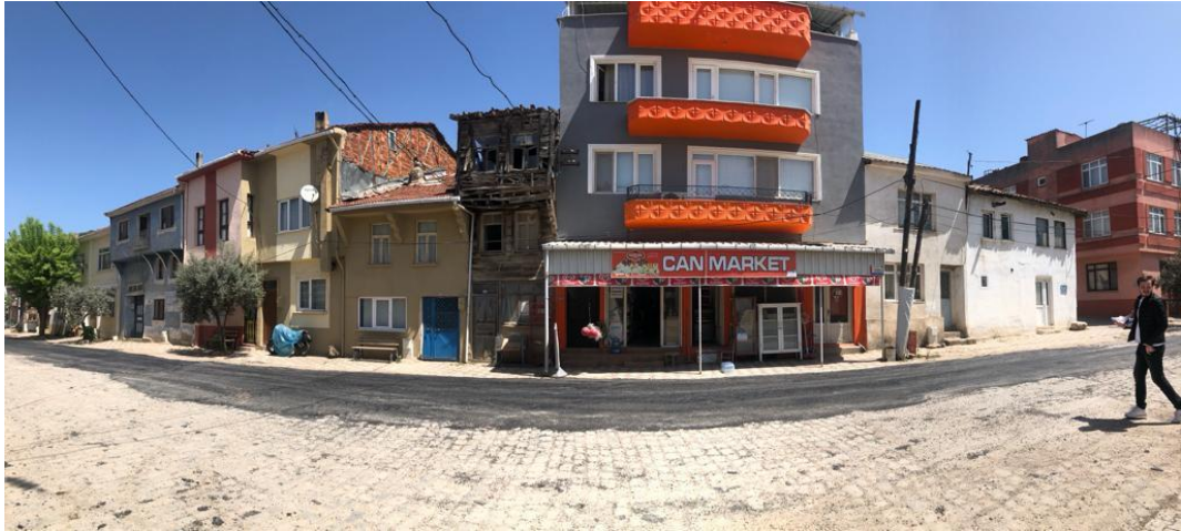
Resim 3.37 C11 – Cephe Görünümü
