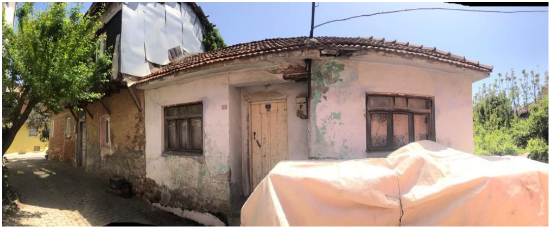
Resim 3.40 C14 – Cephe Görünümü
