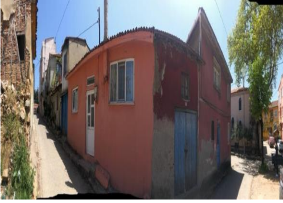
Resim 3.32 C5 – Cephe Görünümü
