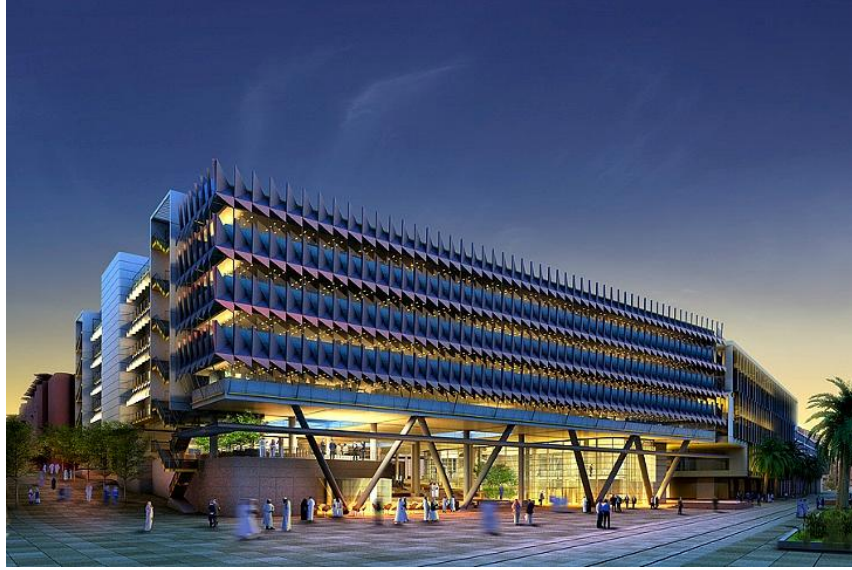
Şekil 3. 18 Siemens Binası Ön Cephe Görünümü (Laylin 2014)
