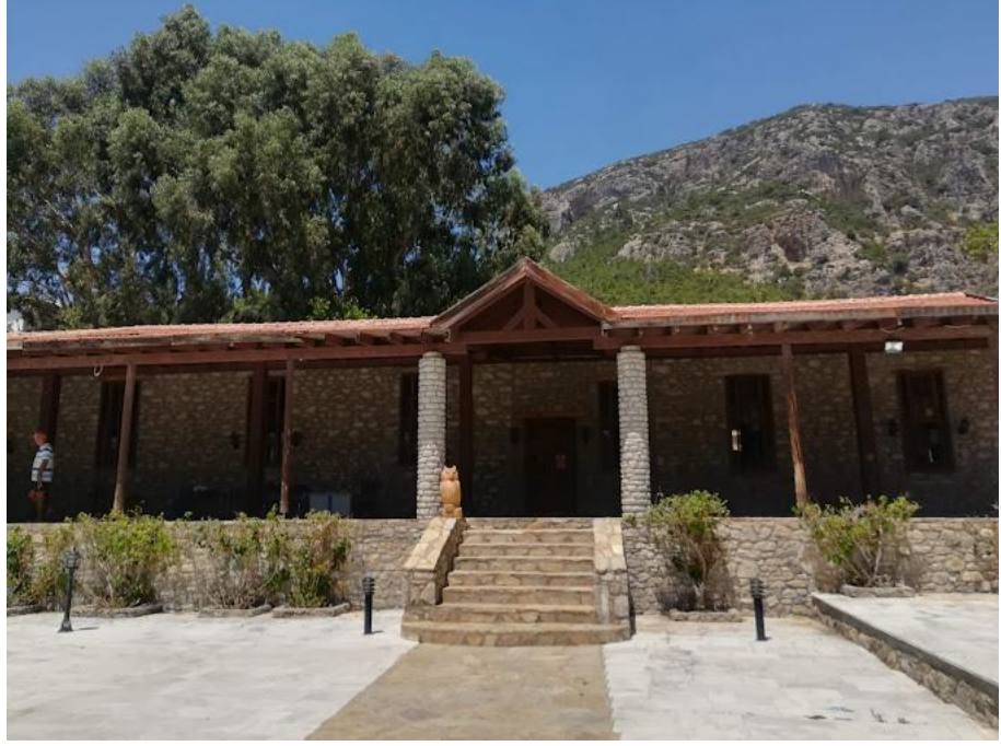
Şekil 4.5 UKKSA Atölye ve Sergi Alanlarının Yer Aldığı Taş Bina, Yaka Köy, Datça, 2021.
