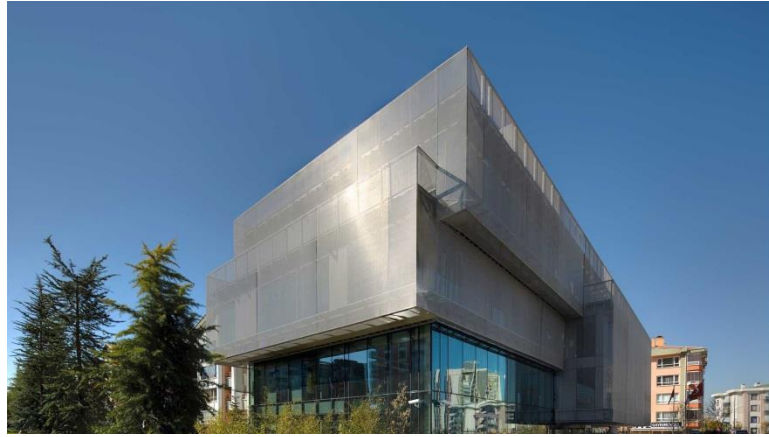
Resim 5.6. Mesh sistemi uygulaması
