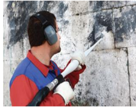
Resim 3.31. Kontrollü kumlama ile temizleme (mekanik yöntem)
