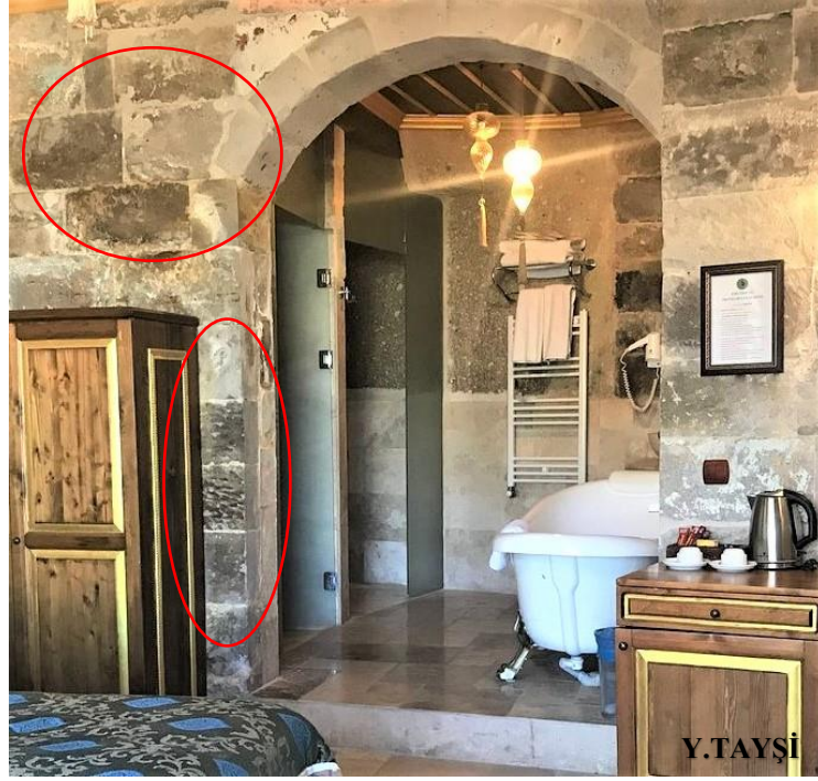
Resim 4.52. Banyo ile yatak odasının tek hacim olduğu oda duvarında görülen doğal bozulmalar
