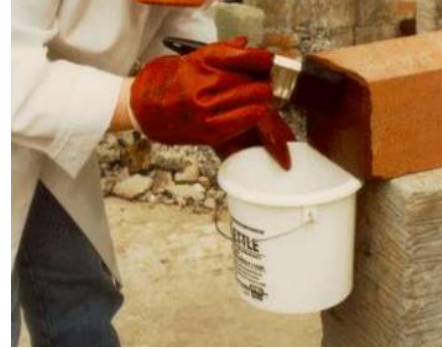
Resim 3.33. Püskürtme yöntemiyle sağlamlaştırıcı uygulaması
