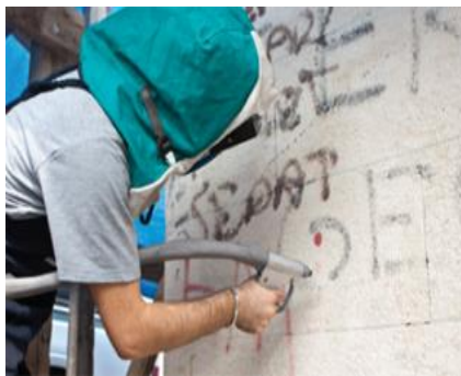
Resim 3.31. Kontrollü kumlama ile temizleme (mekanik yöntem)
