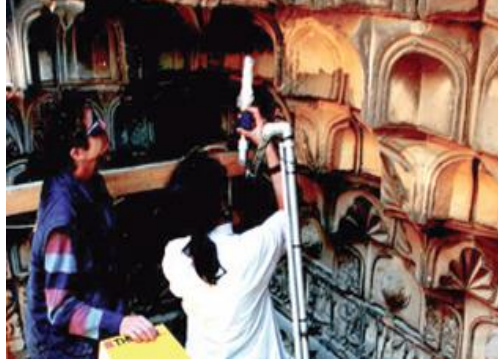
Resim 3.29. Lazer ile temizleme yöntemi
