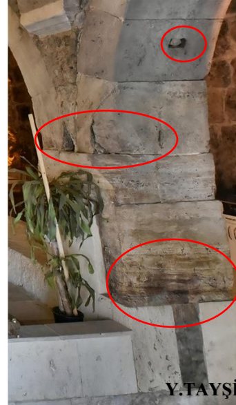
Resim 4.34. ve 4.35. Restorant alanındaki kemerlerde görülen bozulmalar
