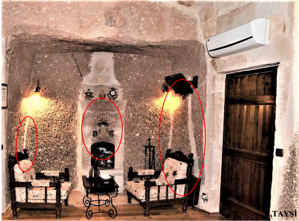
Resim 4.56. Mağara odada görülen yapay (insan kaynaklı) bozulmalar
