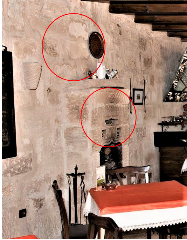
Resim 4.60. Restorant alanında görülen doğal ve yapay bozulmalar
