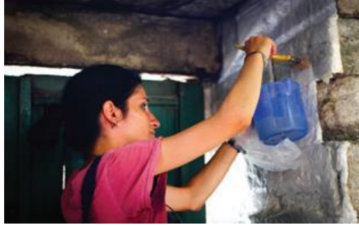
Resim 3.30. Kimyasal maddeler ile temizleme yöntemi
