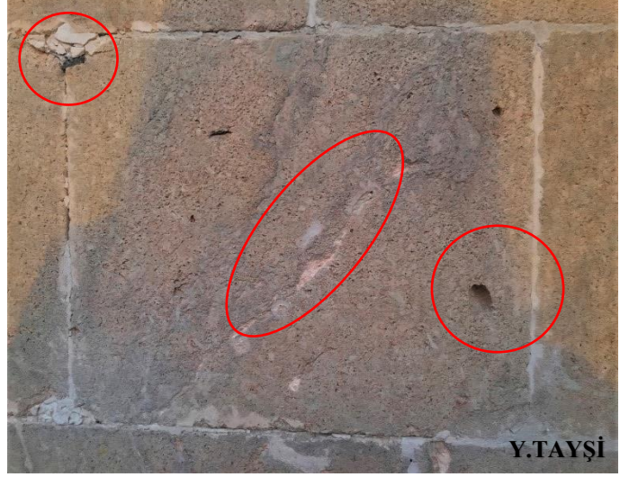
Resim 4.8. Mardin otel odası kapı çevresi aslına uygunsuz malzeme kullanımı
