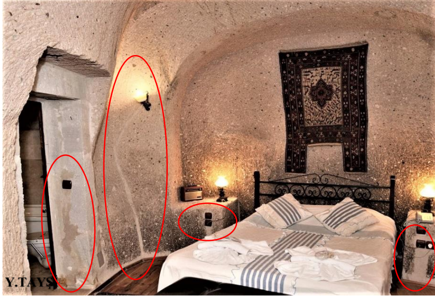
Resim 4.54. Mağara oda tüflerinde görülen hatalı onarım kaynaklı yapay bozulmalar
