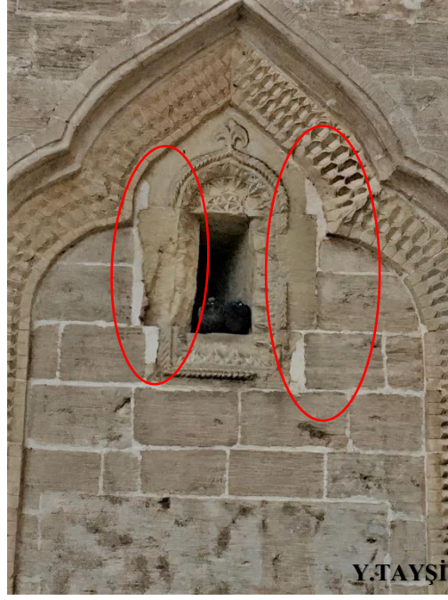
Resim 4.16. Teras alanında kuş dışkıları kaynaklı biyolojik bozulmanın yakın çekimi
