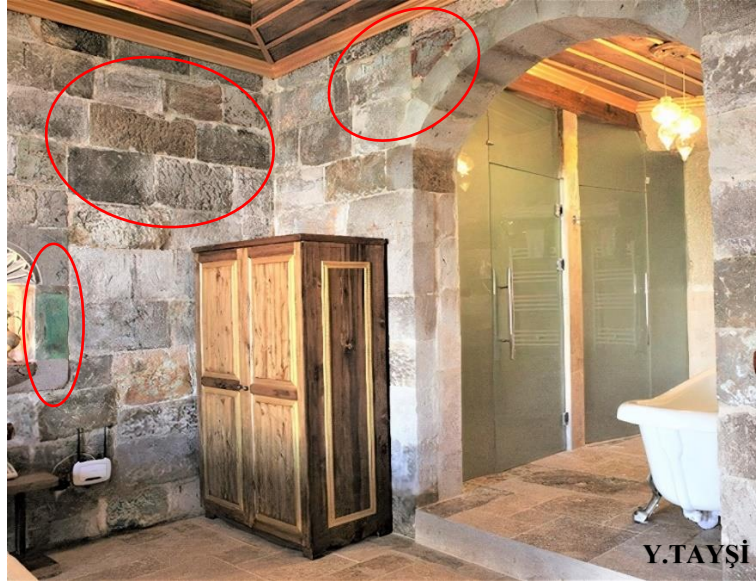
Resim 4.52. Banyo ile yatak odasının tek hacim olduğu oda duvarında görülen doğal bozulmalar
