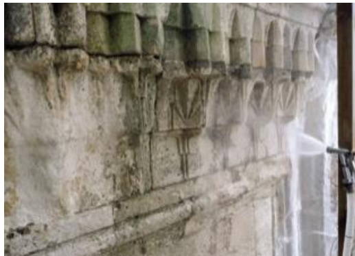
Resim 3.28. Su ile temizleme yöntemi
