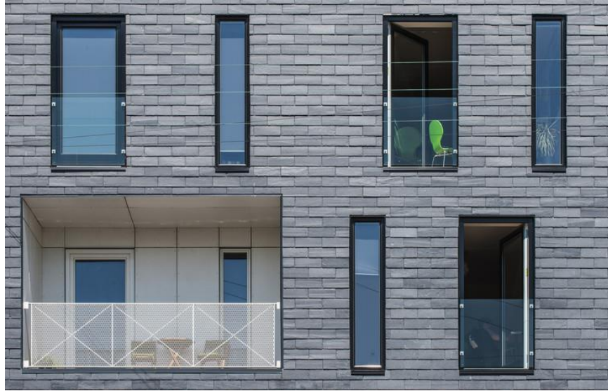
Resim 2.10. Doğal taşın dış cephe kaplaması olarak kullanımı
