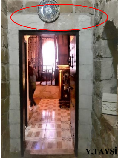
Resim 4.8. Mardin otel odası kapı çevresi aslına uygunsuz malzeme kullanımı
