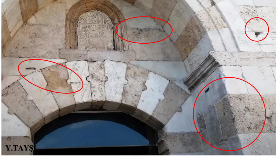
Resim 4.37. Otel restoran ve resepsiyon girişindeki kemer çevresinde görülen bozulma türleri
