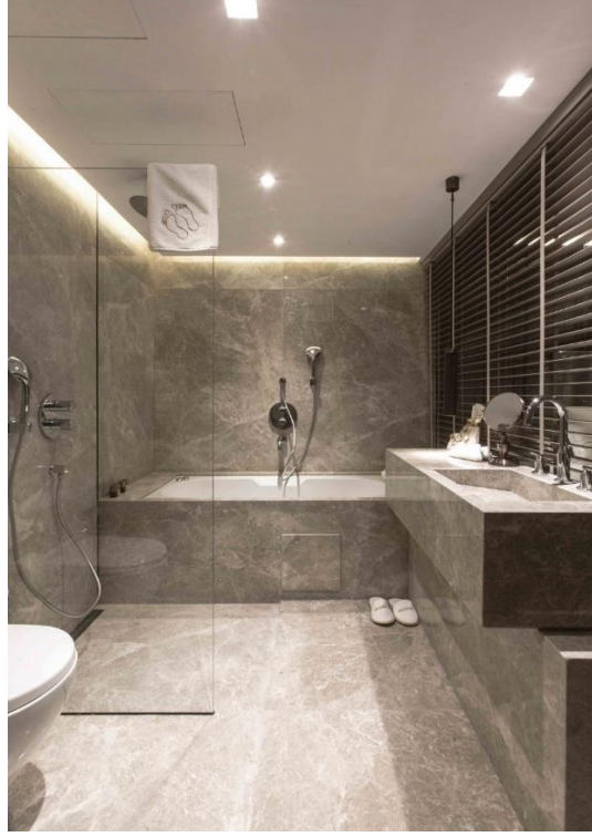
Resim 4.2. Islak hacim zemin, duvar ve tezgah kaplaması
