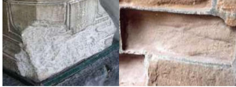
Resim 3.1. ve 3.2. 5 cm'den az yüzey kaybı ve 5 cm'den fazla yüzey kaybı
