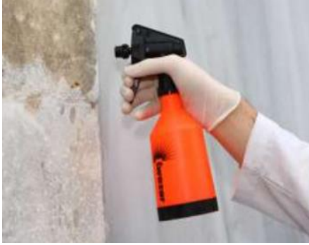
Resim 3.33. Püskürtme yöntemiyle sağlamlaştırıcı uygulaması
