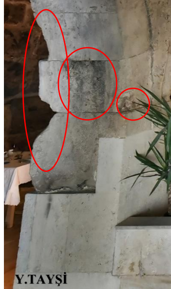
Resim 4.34. ve 4.35. Restorant alanındaki kemerlerde görülen bozulmalar
