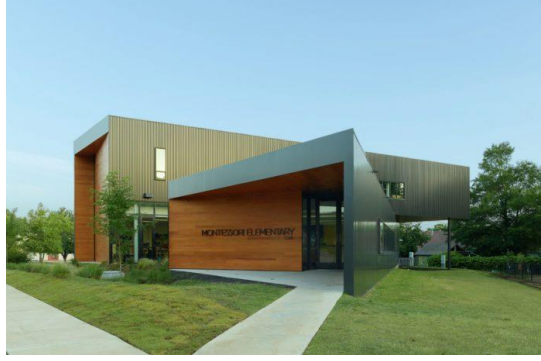
Şekil 5. 21 İki Farklı Geometrik Formdan Oluşan Fayetteville Montessori Okulu
