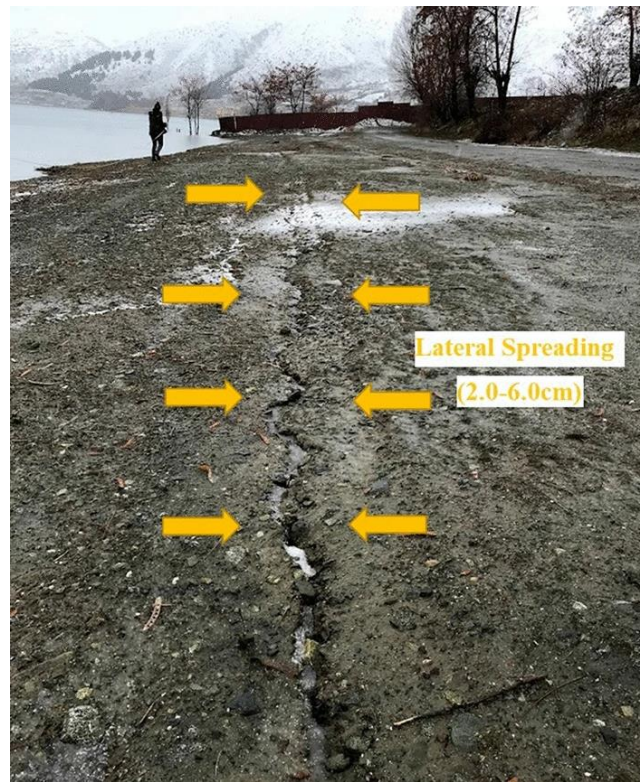
Figure 3.6. Lateral spreading displacement (Sayın, Yön, Onat, Gör, Öncü, Tunç, Bakır, Karaton and Calayır, 2021)
