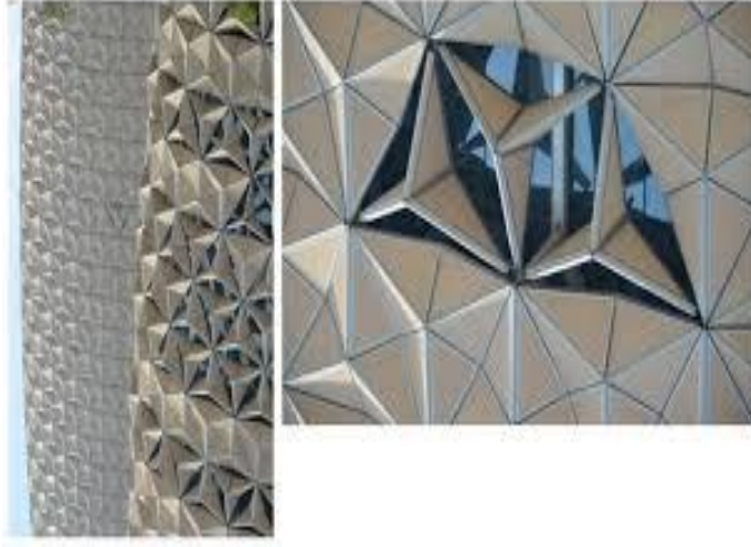
Resim 29 : Al Bahar Kulesi , 2012, Abu Dhabi. (www.arkitektura.al-Al-Bahar-towers).
