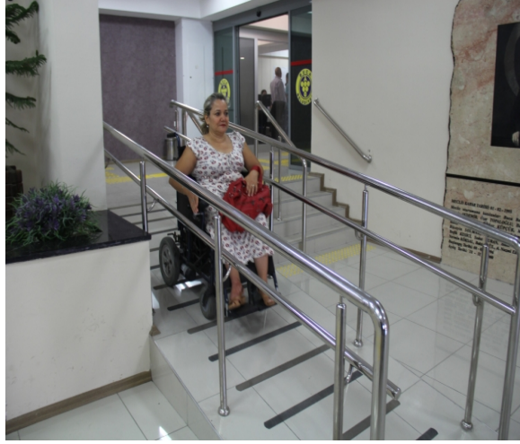
Resim 2. 8. Kamu Binası Girişleri
