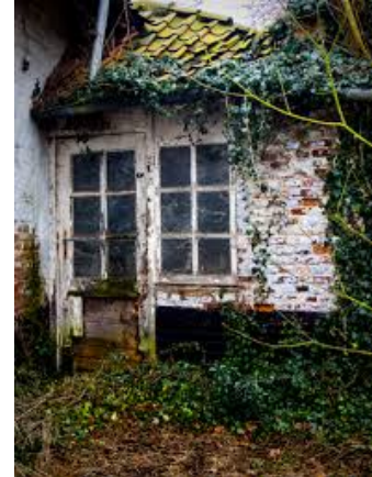
Resim 3.9. Bitkilerin ahşap üze tah.( URL 34) Resim 3.10. Rüzgarın ahşap üze tah.(URL 35)
