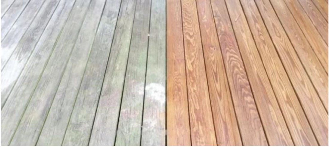
Resim 3.7. Ahşabın ısıl etki karşısında renk değişimi (URL 32)
