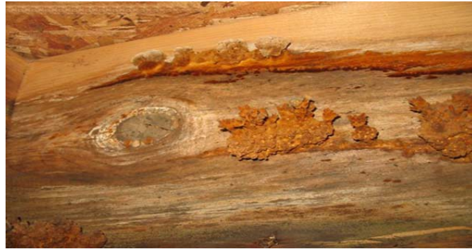
Resim 3.12. Nem ve ısı ile ahşap malzemedeki bakteri ve mantar etkisi (URL 37)
