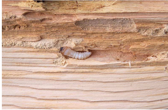
Resim 3.11. Böcek ve kurtların ahşap üzerindeki tahribatı (URL 36)
