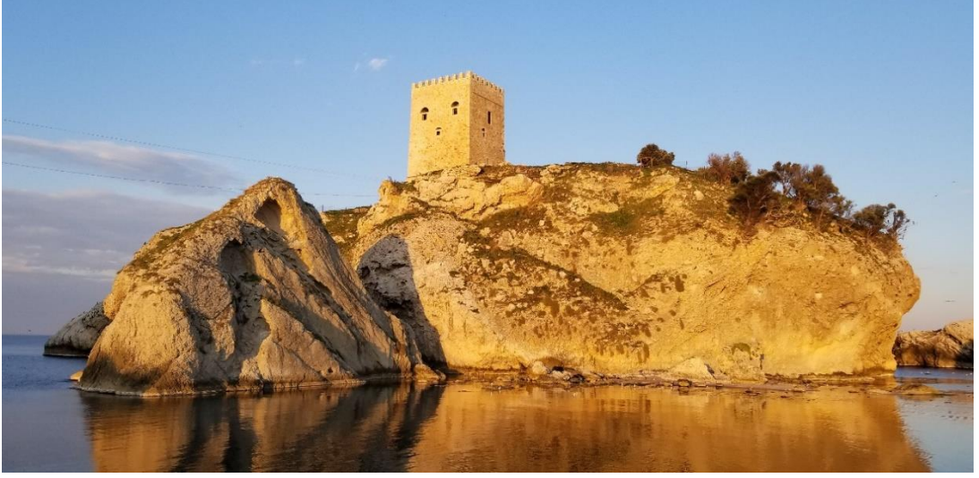
Şekil 5.2 Şile Ocaklı Ada Kalesi
