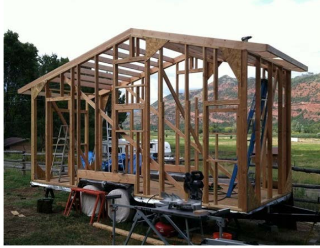
Şekil 3.5 Ahşap çerçeveleme örneği
